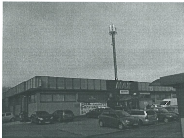
Zoł. nr 1: Widok ogólny instalacji radiokomunikacyjnej.
