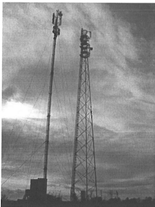
Zał. nr 1: Widok ogólny instalacji radiokomunikacyjnej.
