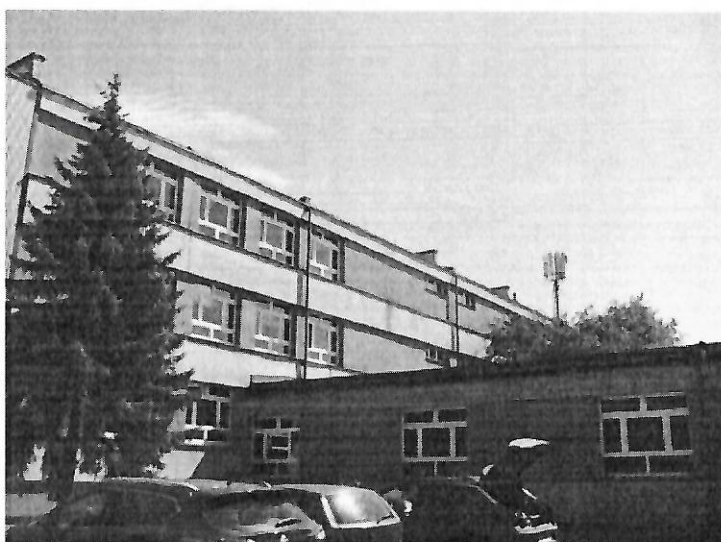
Zał. nr 1: Widok ogólny instalacji radiokomunikacyjnej.
